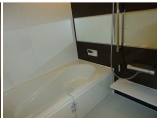
203:浴室（浴室換気乾燥機、追い焚き給湯）
